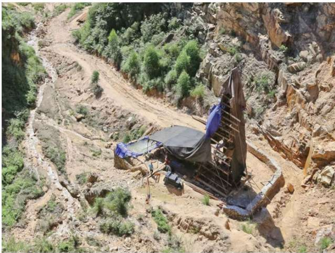
Рисунок 1. Строительство шахты, ведущей к детектору JUNO
