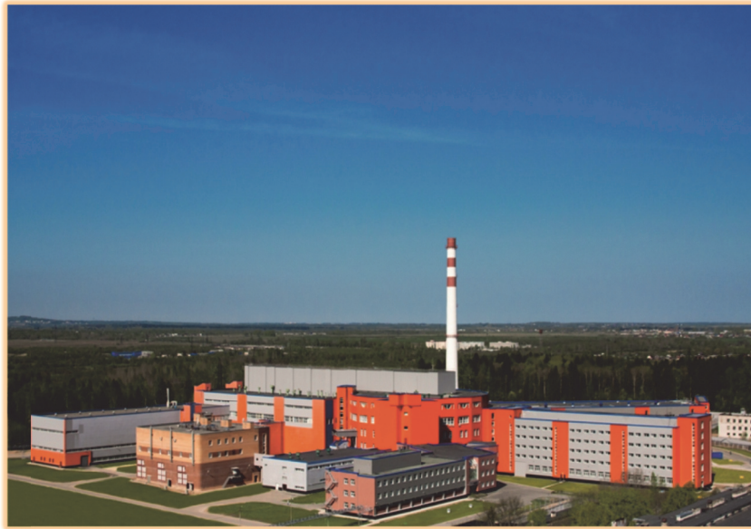
Рис. 9.1.2. Фото реакторного комплекса ПИК
